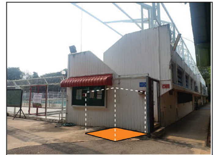
SPC02 : ข้างสระว่ายน้ำชนเห็นชอบ ขนาดพื้นที่ 2x2 ม. = รวม 4 ตร.ม.
